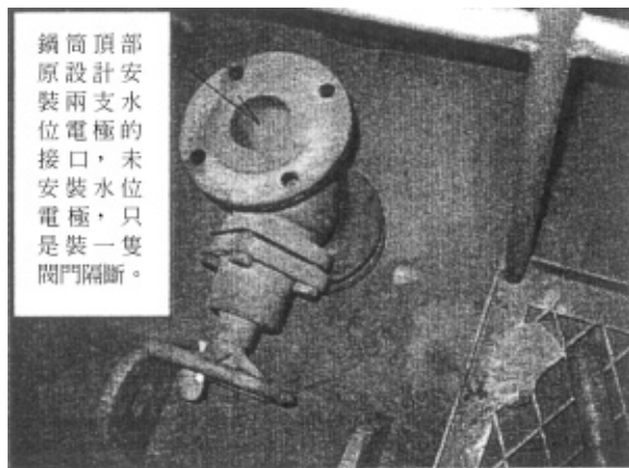
圖 5 鍋筒頂部閥門隔斷
