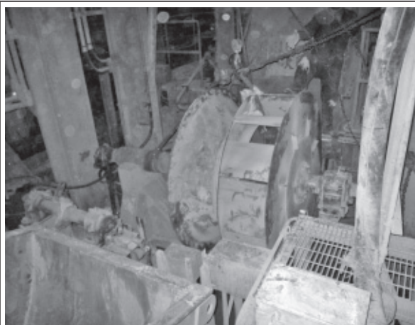
1. 拆一次風扇保溫外蓋，將舊有一次風扇葉輪組件拆出。
