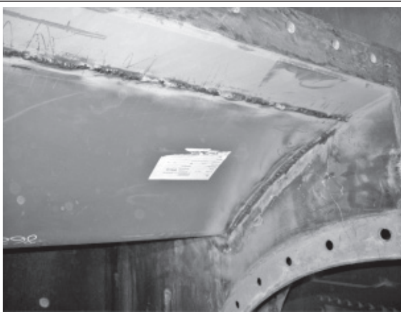
2. 因加大葉輪，作葉輪外殼修改，以符合風扇效率與運轉安全。
