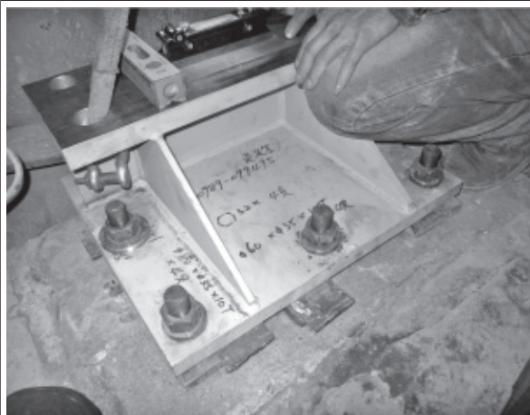
3. 軸承座水平與垂直校正後，以原固定螺栓搭配耐高壓快乾水泥來固定軸承基座。
