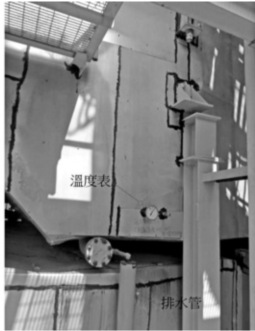
圖 2 省煤器溫度表配置圖與實際照片
