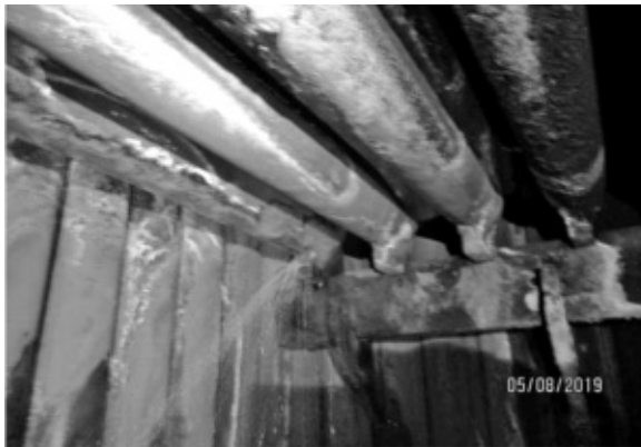
圖 3 破管漏水
