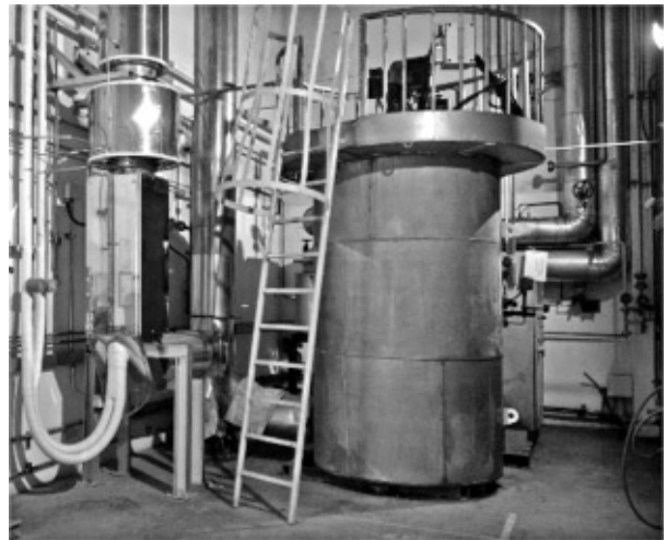
圖 5 熱電發電系統安裝於熱煤鍋爐煙道
