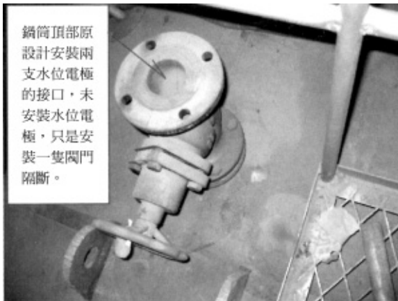
圖 5 鍋筒頂部閥門隔斷
