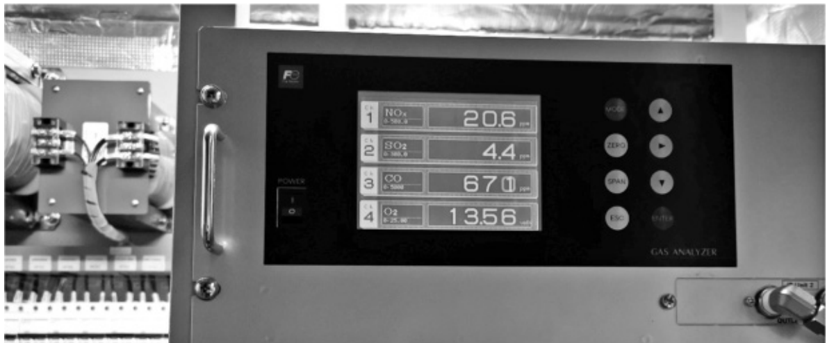
圖 6 某紡織廠 CEMS 顯示面板（資料來源：環興公司/某紡織廠）
