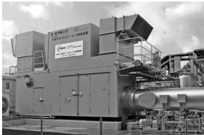
圖 12 氫發電之例（燃氫瓦斯渦輪）
