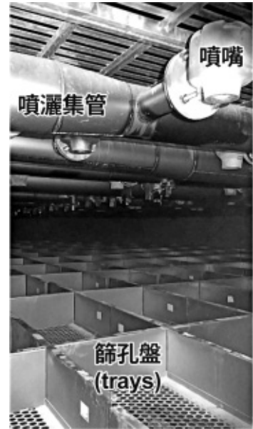
圖 9 噴灑集管、噴嘴&篩孔盤
