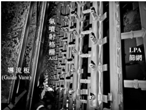
圖 6 LPA 篩網、氨噴射格柵&導流板
